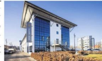
Pier 5 Hotel hed tidligere Slotshotellet og er nu genåbnet efter en omfattende renovering. Den attraktive beliggenhed på Aalborgs havnefront er der ikke nok at sige. Foto: rosfoto.dk
